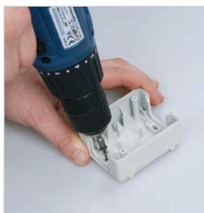
Прикрепить основание выключателя к стене двумя шурупами, предварительно сняв сальники.
