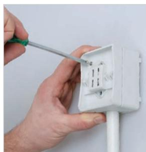
Установить лицевую панель выключателя при помощи винтов-саморезов
