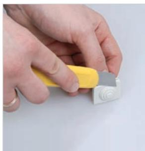
Рекомендуется срезать выступ сальника нужного диаметра для проводки кабеля и стыка с трубой ТМ IEK
