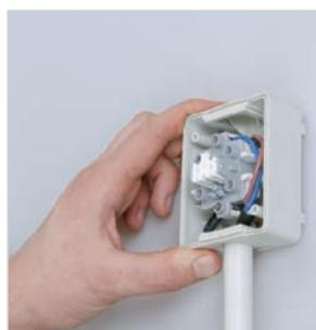
Установить механизм с подсоединенными проводниками в основание выключателя в соответствии с направляющими
