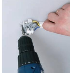
Заднюю пластину вместе с механизмом прикрепить к стене при помощи двух винтов-саморезов
