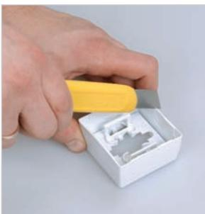
При наружном монтаже (например, при стыке с кабель-каналом серии «Элекор» или трубами ТМ IEK) рекомендуется отрезать часть лицевой панели выключателя по имеющимся насечкам
