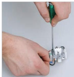
Подсоединить проводники к механизму выключателя
