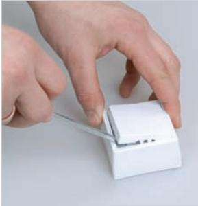
Приподнять клавишу выключателя при помощи отвертки
